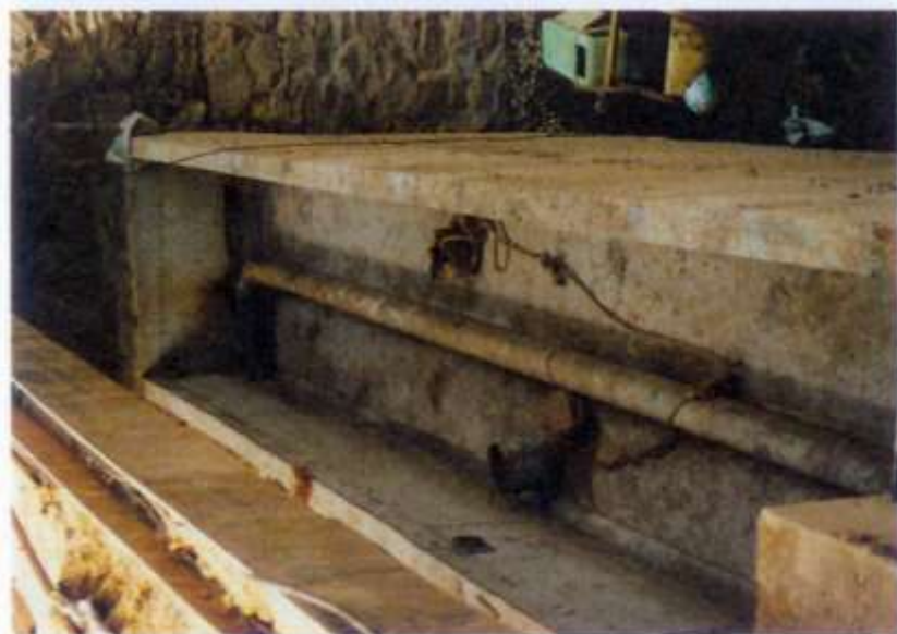
图 3-42 瀑布蓄水池内部供水管和出水口安装
