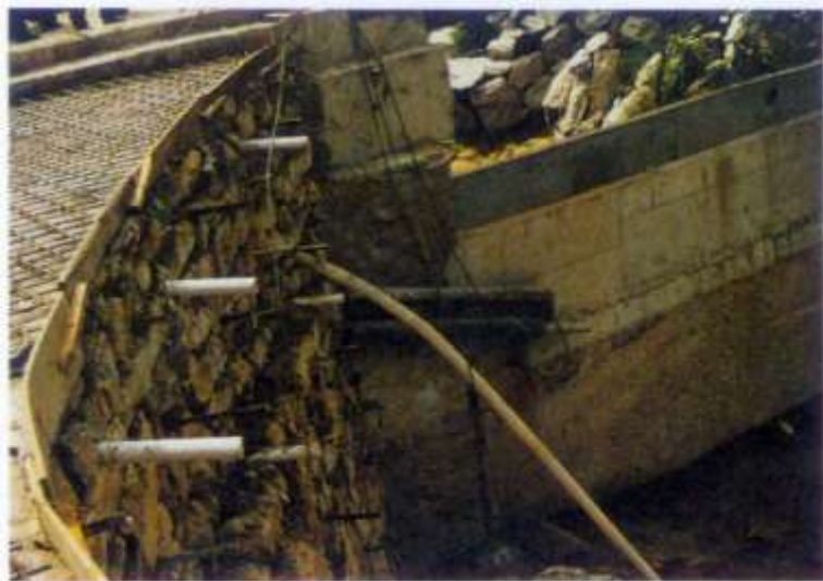
图 3-43 瀑布背面细部施工，其中黑色管为瀑布蓄水池供水管，侧面墙体钢筋为人工岩贴面预埋铁
