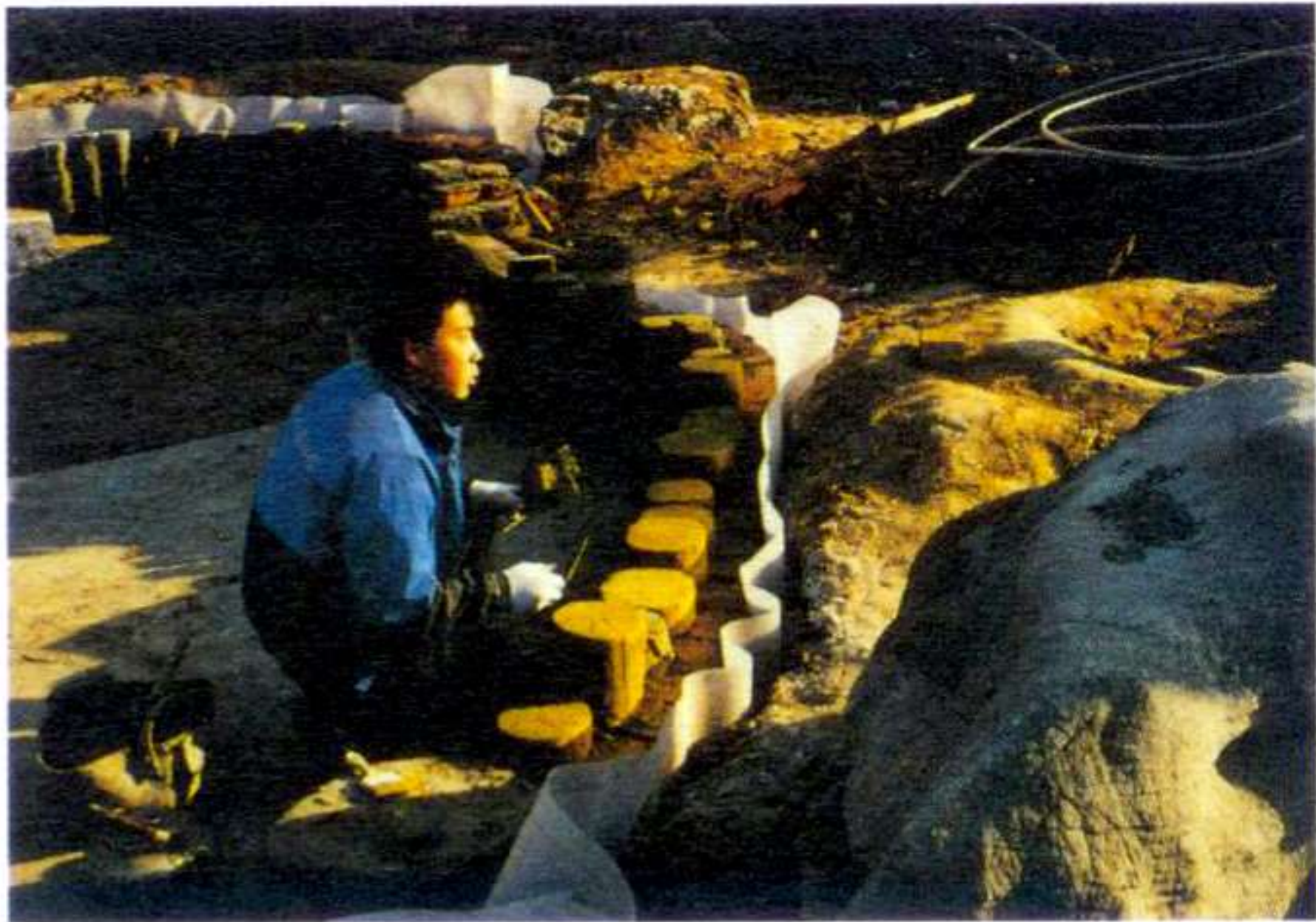
图 1-58 小型水池用混凝土塑造仿木柱驳岸
