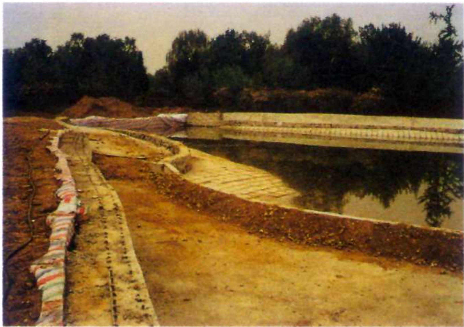
图 1-53 根据设计的要求，做不同位置、大小、深度的种植池，并填入培养土
