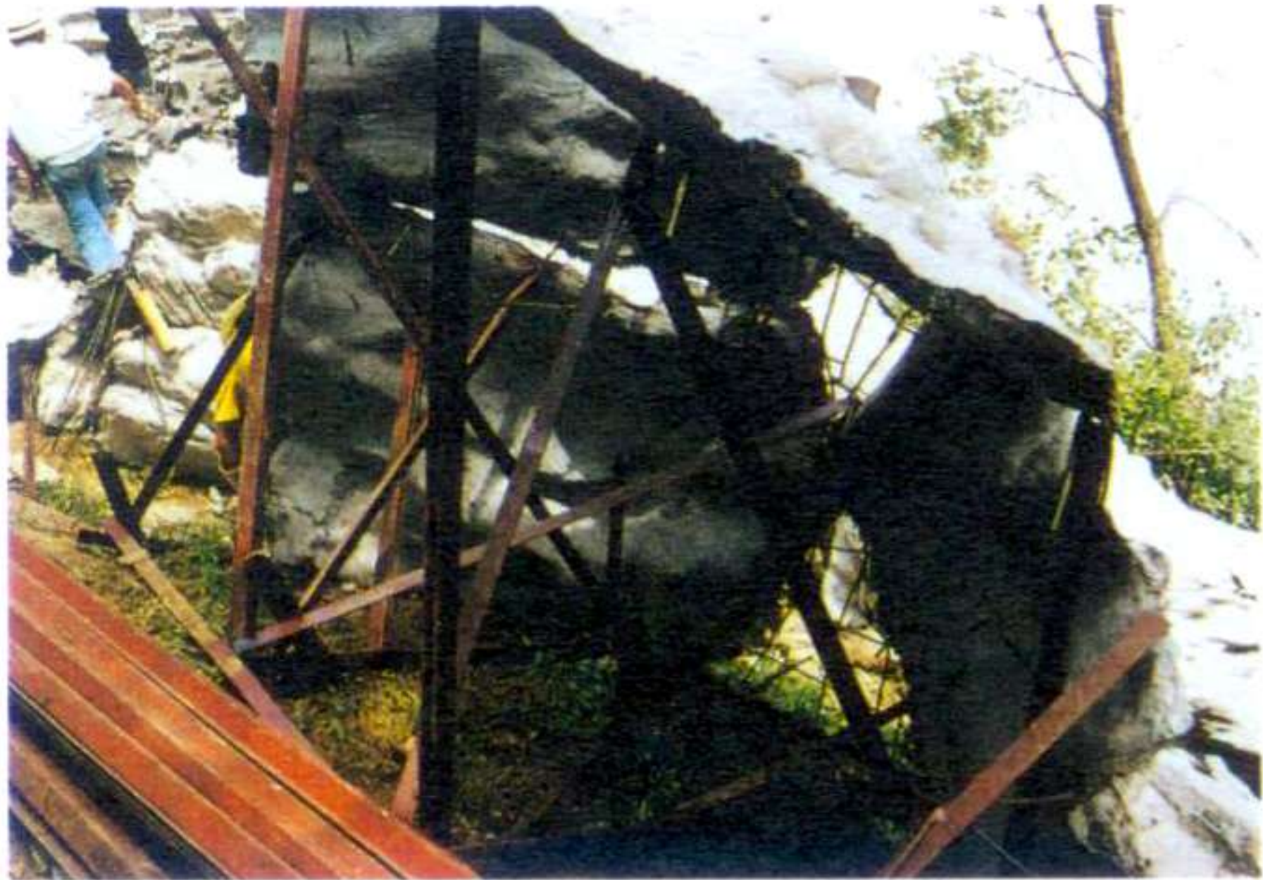
图 1-56 人工岩安装时内部的钢结构
