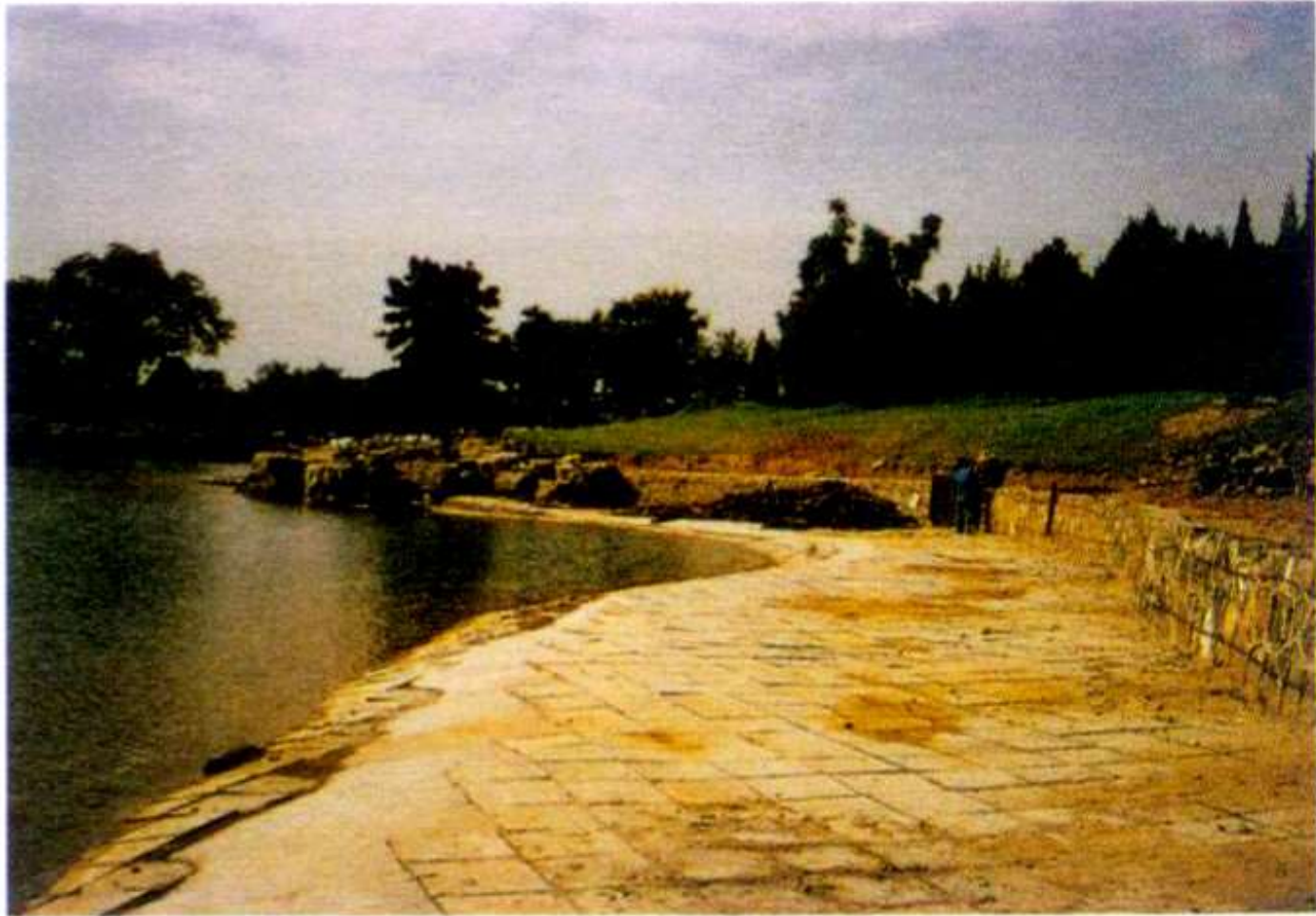
图 1-59 为了游客的安全，设计规范要求，岸边2m以内水深不得超过0.7m，所以有时在近岸边要将湖底抬高，以确保安全
