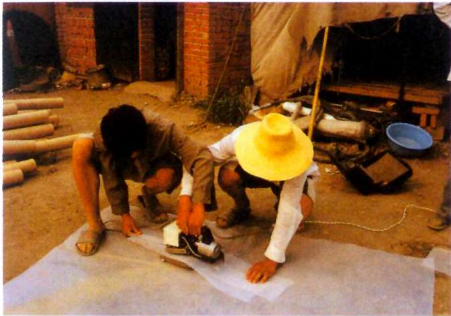
图 1-51 聚乙烯防水层焊接示范
