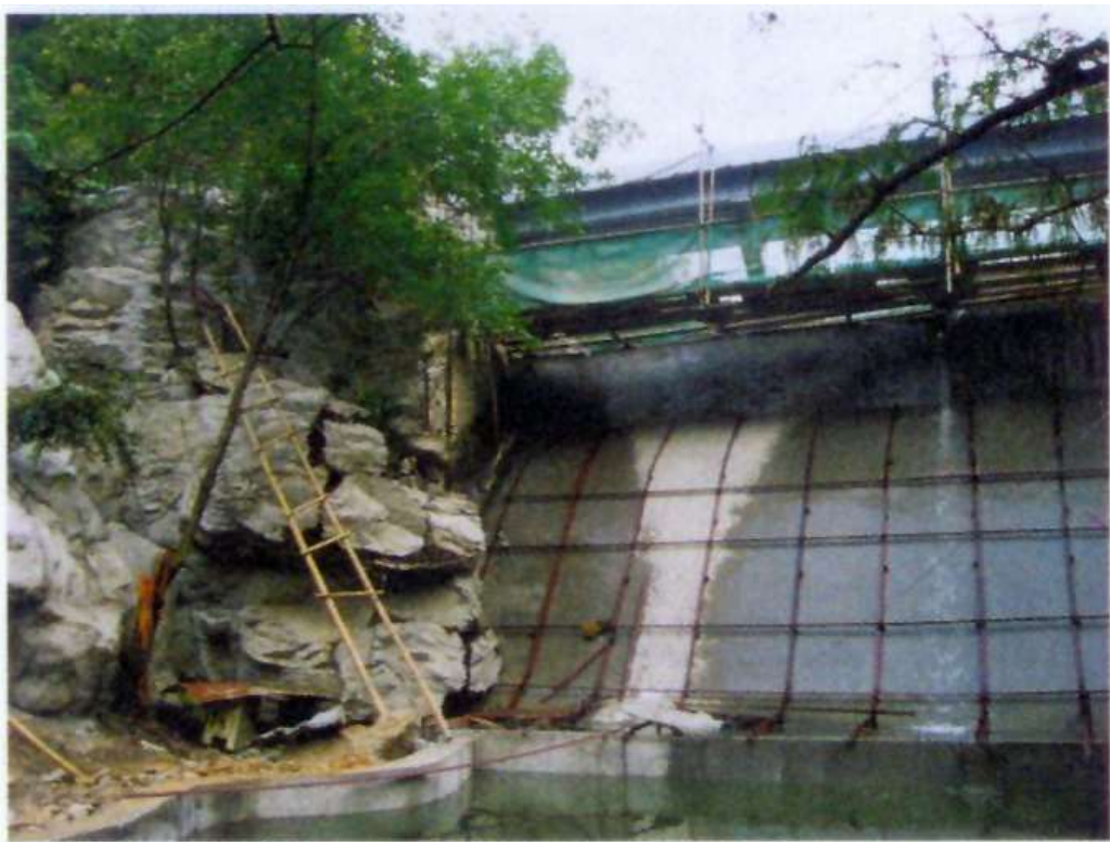
图 3-44 人工岩假山岩体安装
