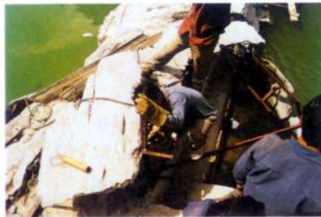
图 3-46 人工岩岩体焊接
