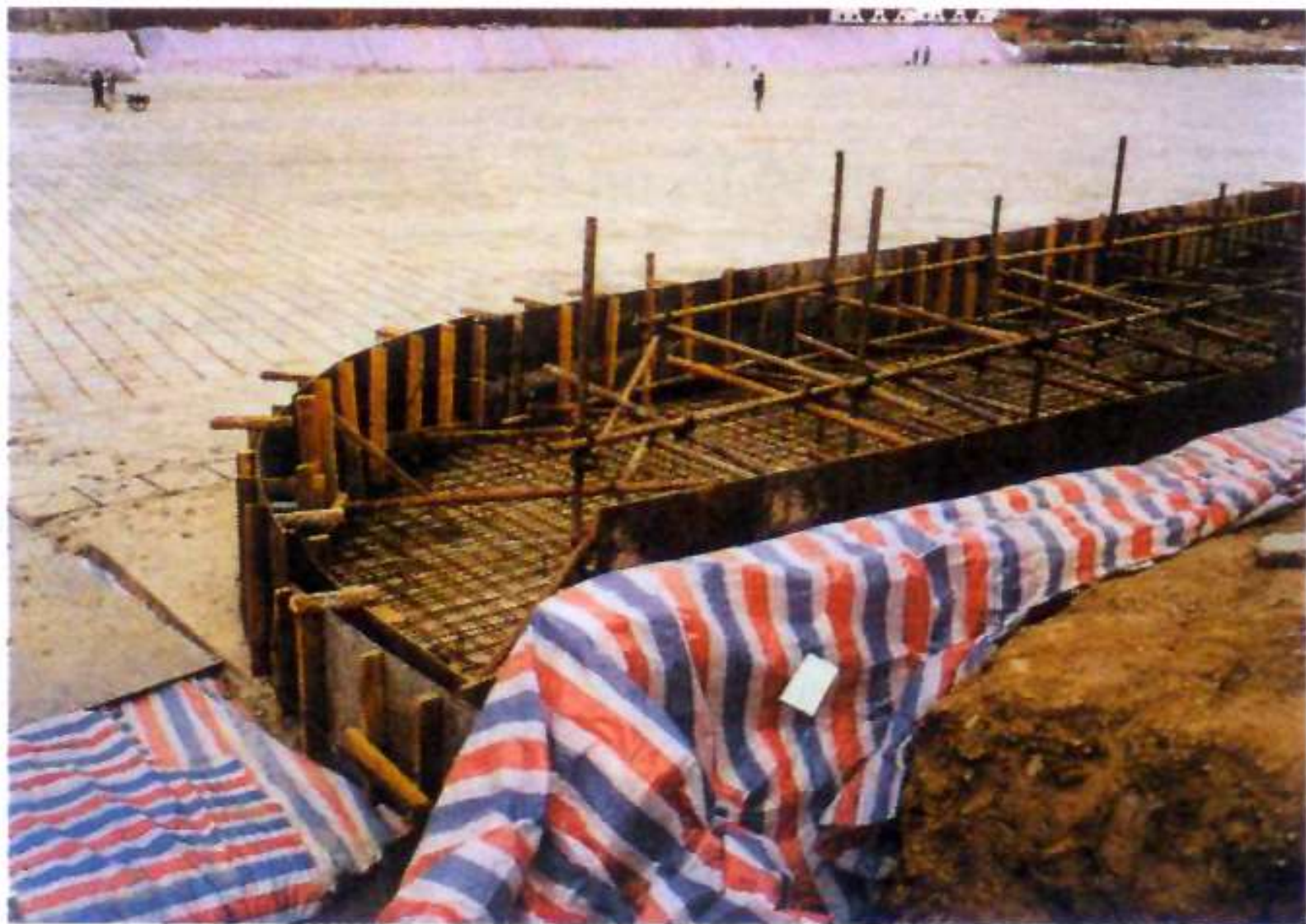
图 1-52 湖底平铺混凝土砖进行保护，岸边种植池在准备浇注混凝土
