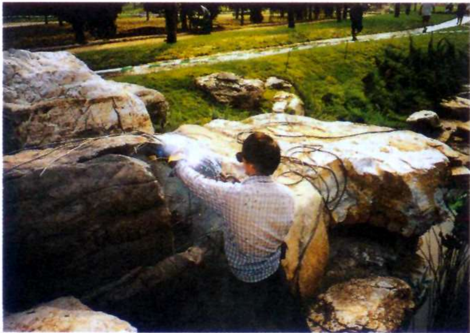
图 1-55 人工岩护岸时，工人正在用电焊接固定“石块”
