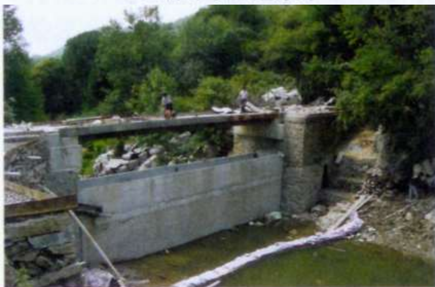
图 3-37 瀑布所在地原地貌，利用此原水坝塑造瀑身
