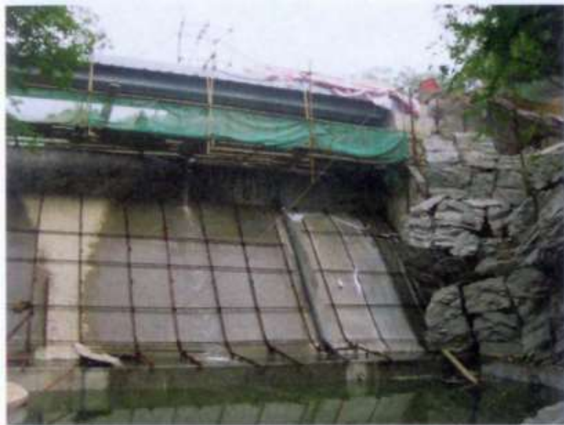
图 3-41 塑人工岩瀑身时做主体钢架结构
