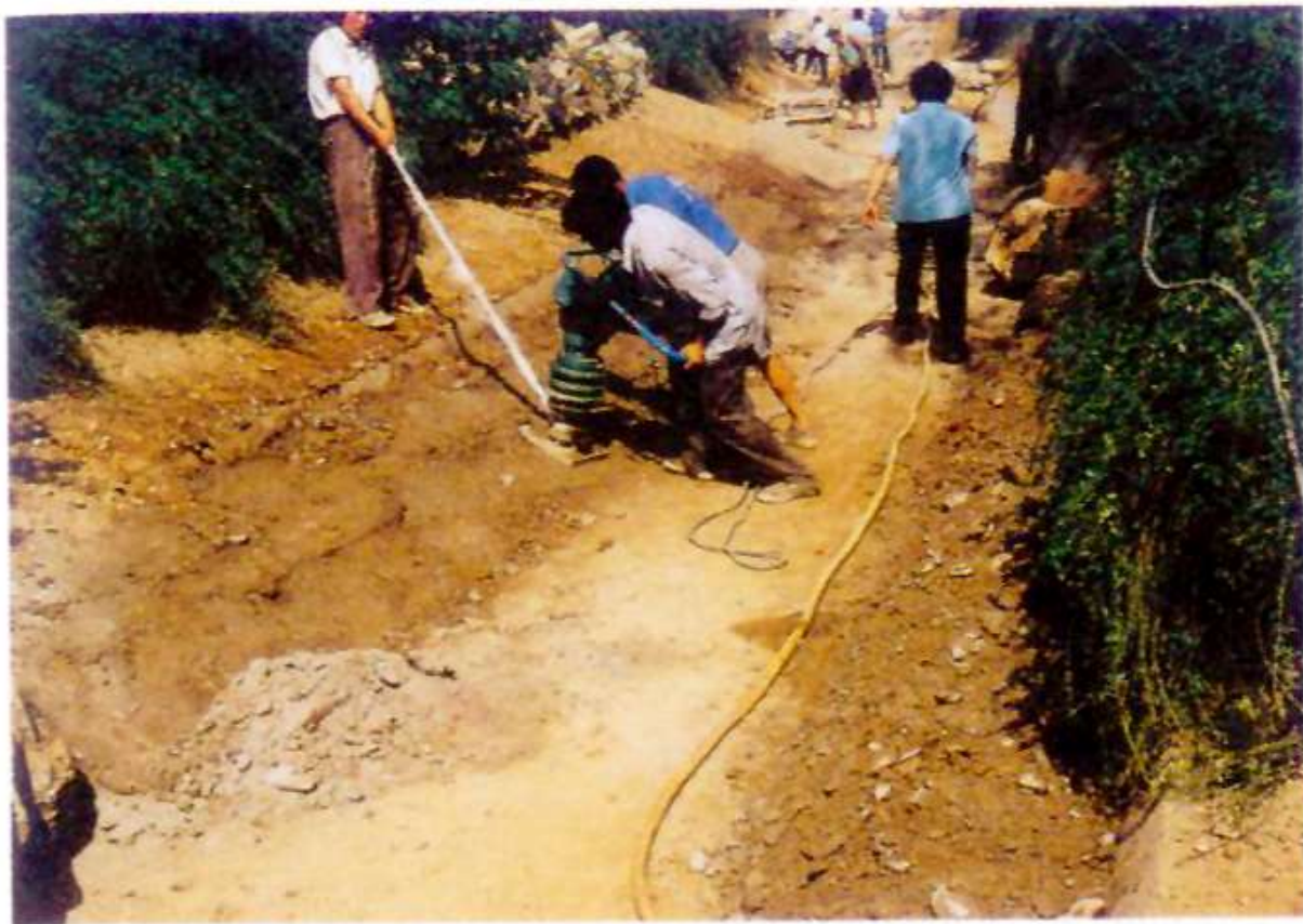
图 2-30 小溪边自然式缓坡岸壁，为防止冲刷，用土壤固化剂固定边坡土壤，并有一定的防渗作用
