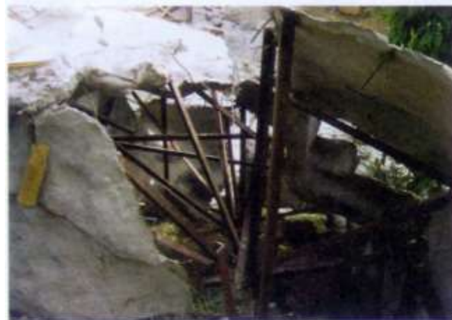
图 3-45 人工岩岩体内部拉筋配置
